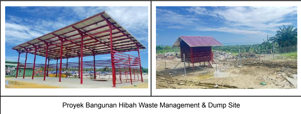
Konsul RI melakukan kunjungan dalam rangka pengamatan proyek bangunan hibah
